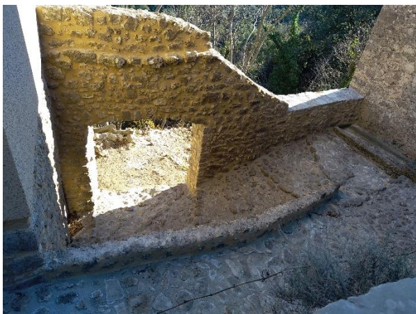
Réfection de la calade et des joints de la muraille
